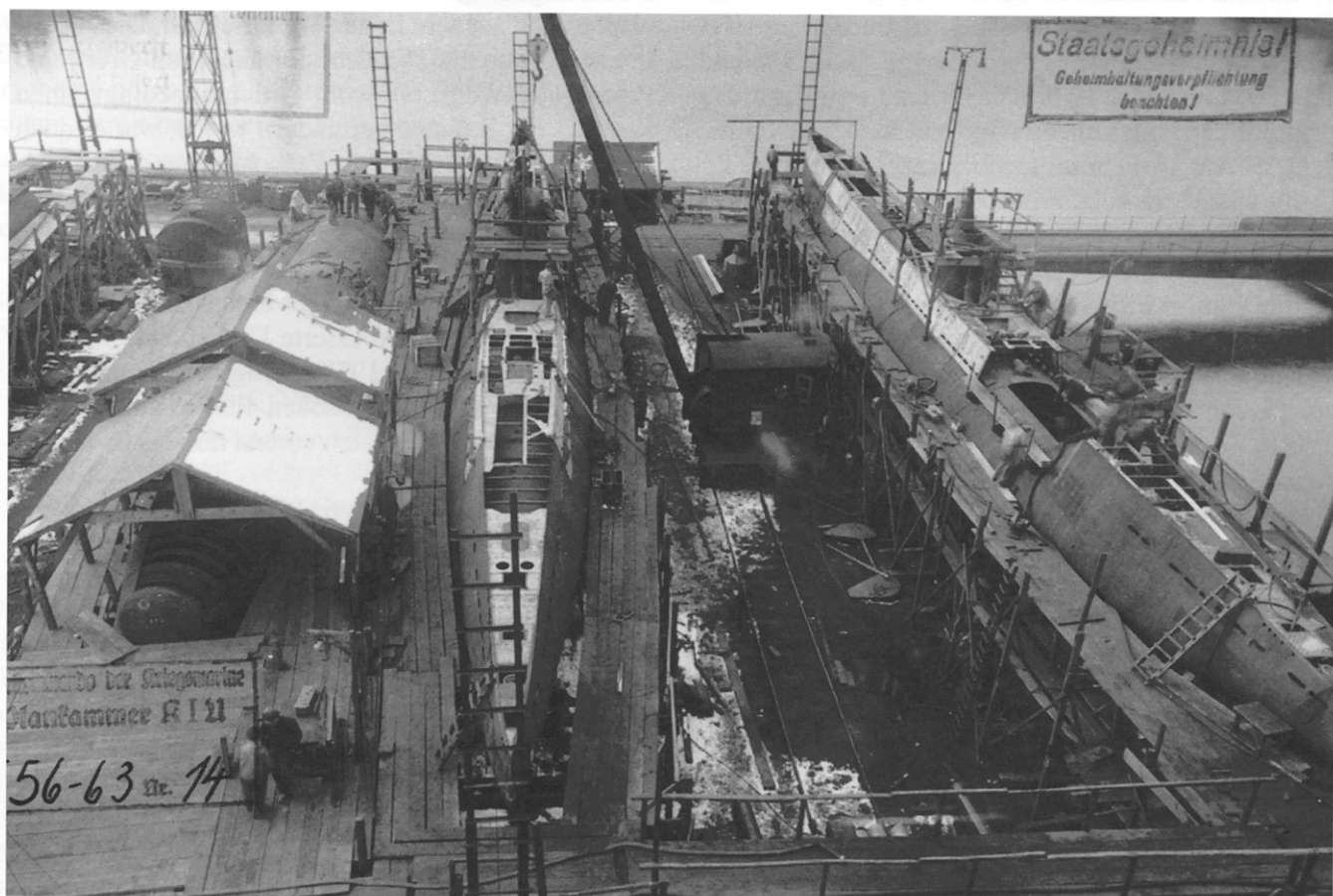
Typ II C-Boote am 22. März 1939 in verschiedenen Baustadien. Von rechts nach links U 60, U 61 und U 62.
