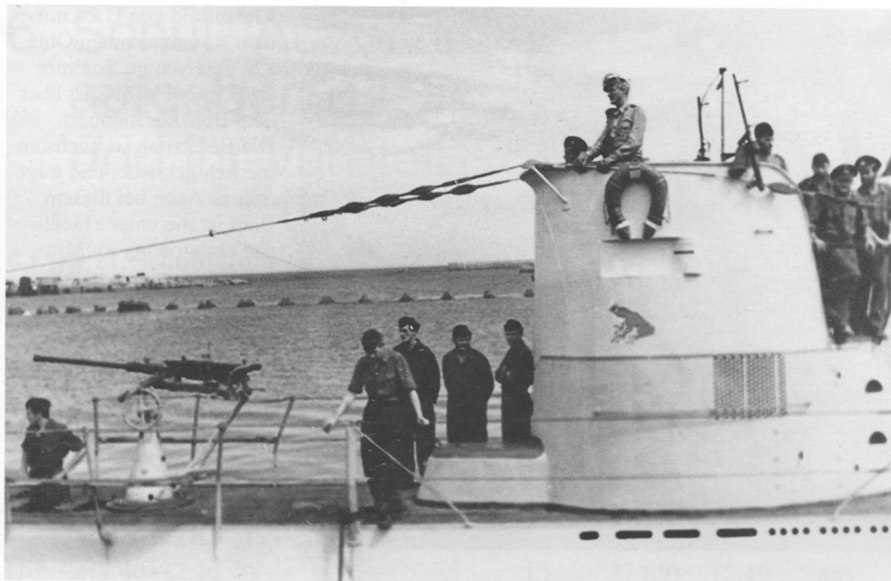
U 20 mit angebautem ‚Wintergarten‘ an die Brücke läuft im Sommer 1943 in Konstanz ein. Das Uboot besitzt jetzt je eine 2 cm-Flak in Einzellauffette auf der Brücke und dem Vorschiff.
