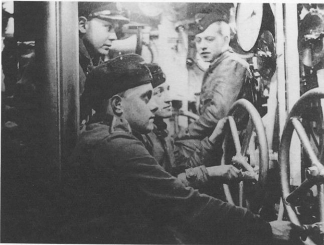
Ausbildung am Tiefensteuergerät (Roedersches T-Gerät) in der Uboot-Schule.
