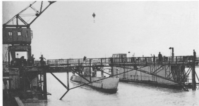
U 9 ausgedockt nach der Wiederherstellungsmontage in Galatz. Das Boot hatte dabei zusätzliche Flutschlitze am Vorschiff erhalten.
