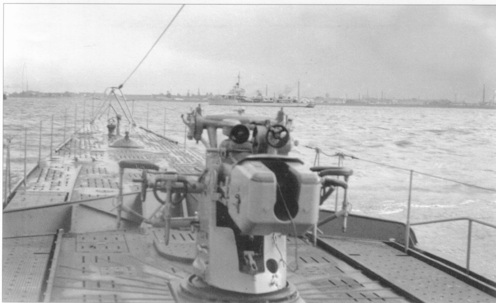
U 106 (Typ IX B), pokładowe działo 10,5 cm SK C/35 • U 106 mounting the 10.5 cm SK C/35 deck gun.
