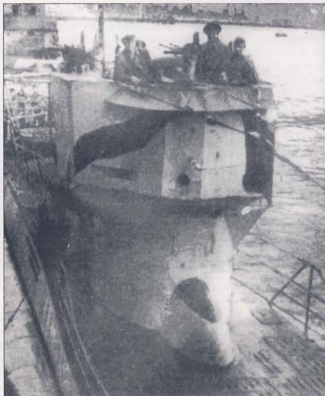
U-711 под командованием Ганса-Гюнтера Ланге входит в порт после боевого похода. У-бот - тип VIIС поздней постройки. Лодка окрашена по двухцветной «разушающей» камуфляжной схеме: полосы темно-серого цвета поверх светло-серой базовой основы. За морями просматриваются два спаренных 20-мм зенитных автомата. Ланге вступил в командование субмариной U-711 26 сентября 1942 г. Свою карьеру в качестве командира У-бота Ланге начал с расстрела из орудий двух русских радиостанций в районе Печоры. Ланге действовал против Северных конвоев на подступах к Мурманску. Ланге торпедировал, но не потопил линкор «Архангельск». 26 августа подводник был награжден рыцарским крестом, а 29 апреля 1945 г. - Дубовыми листьями. Субмарины U-711 потопил британский самолет 5 мая 1945 г. в Харштаде, однако Ланге вместе с несколькими моряками из состава команды удалось спастись.
