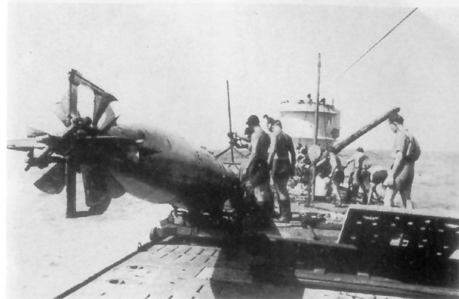
Auf hoher See werden Torpedos aus den Oberdecks-Tuben in den Bug Torpedoraum umgeladen.
